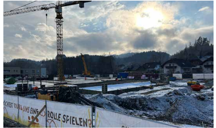
Der Bau geht zügig voran: Anfang Dezember sind bereits die Bodenplatten betoniert.
