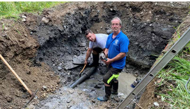
Die Reparaturen von Wasserrohrbrüchen sind immer besondere Herausforderungen. Unsere Mitarbeiter Andreas Kölz und Will Klatzer beim „Flicken“ einer Leitung in Tigring.
