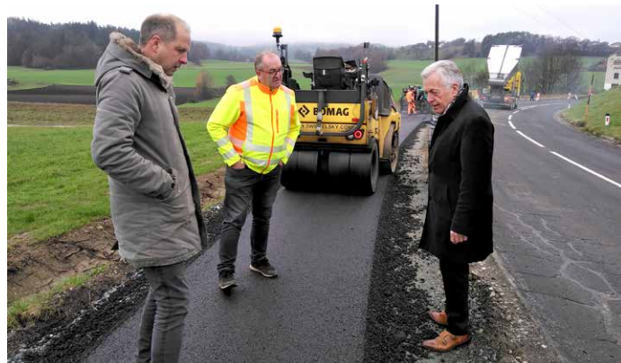
Bauleiter Günther Gfreder, Hermann Koraschnig und Bürgermeister Herbert Gaggl bei einer Baukontrolle (von links).
