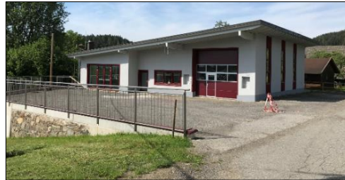
BÄRNDORF, BLICK VON STALLHOFEN AUS (L.) RÜSTHAUS DER FFW (R.)
