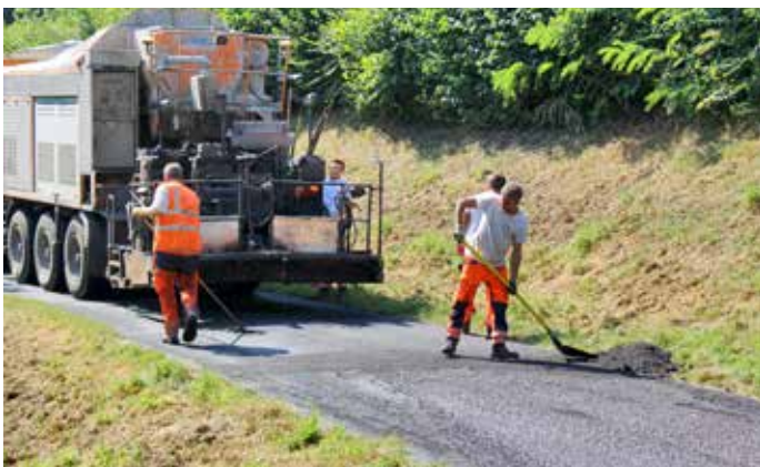
Ein kostensparendes Verfahren: Dünne Asphaltdeckschichten werden in den Straßenkörper eingebaut.
