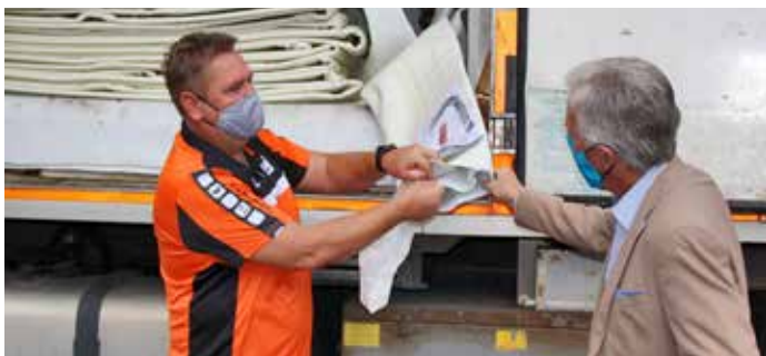
In die desolaten Kanalleitungen wurden „Inliner“ eingezo-gen. Sie verhindern, dass Abwässer durch Risse und Löcher in den Boden gelangen.
