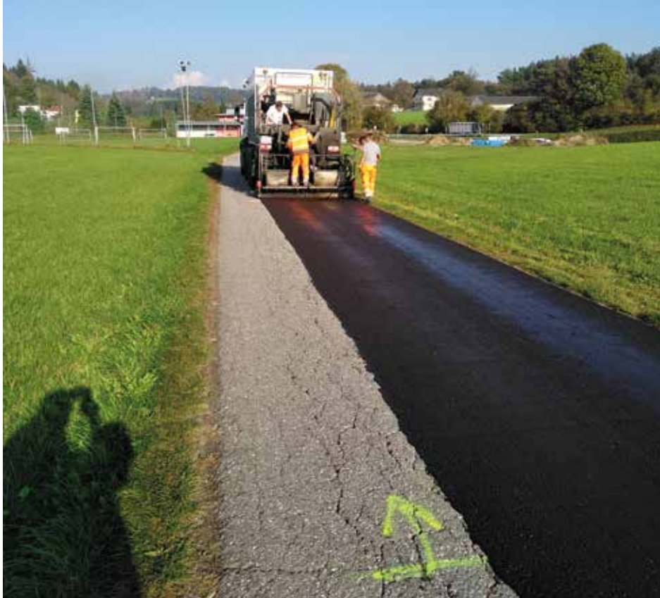
Mit einem neuen Kaltasphaltverfahren wurden die Straßen saniert. Im Bild: Kreggaber Straße.
